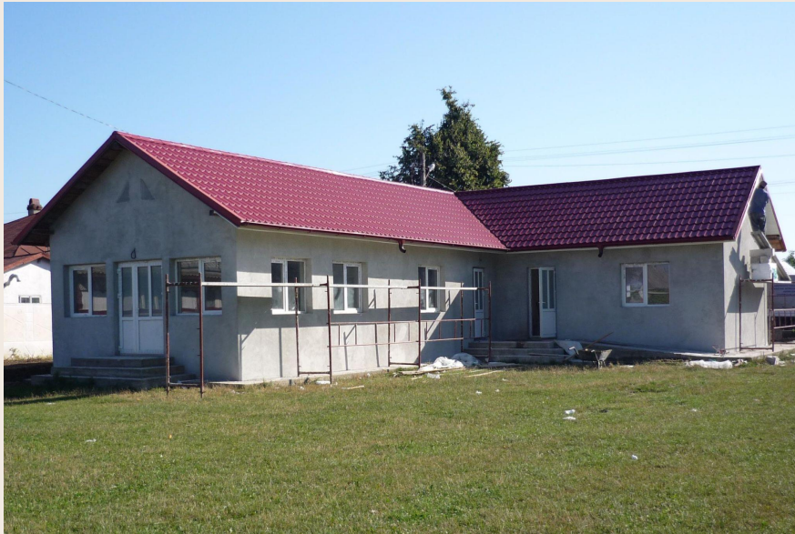
Costruzione Scuola Materna a TRAIAN in Romania
